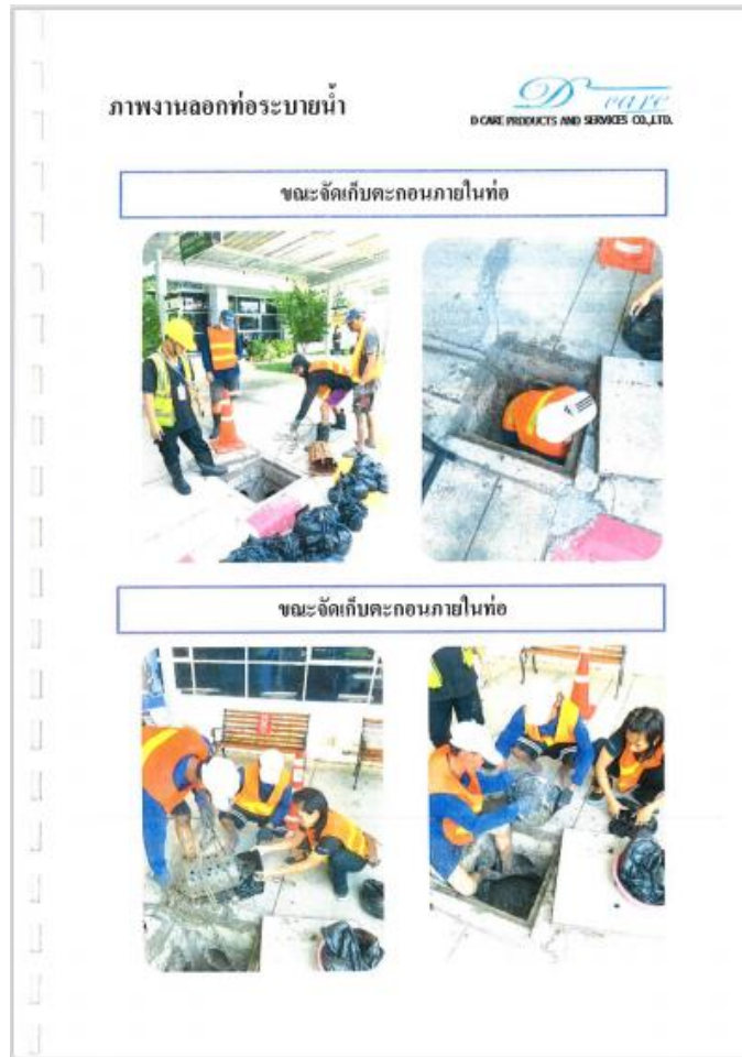
ภาพที่ 2.3.3-4 การปฏิบัติงานลอกท่อและเก็บขยะในท่อระบายน้ำวิทยาลัยฯ
